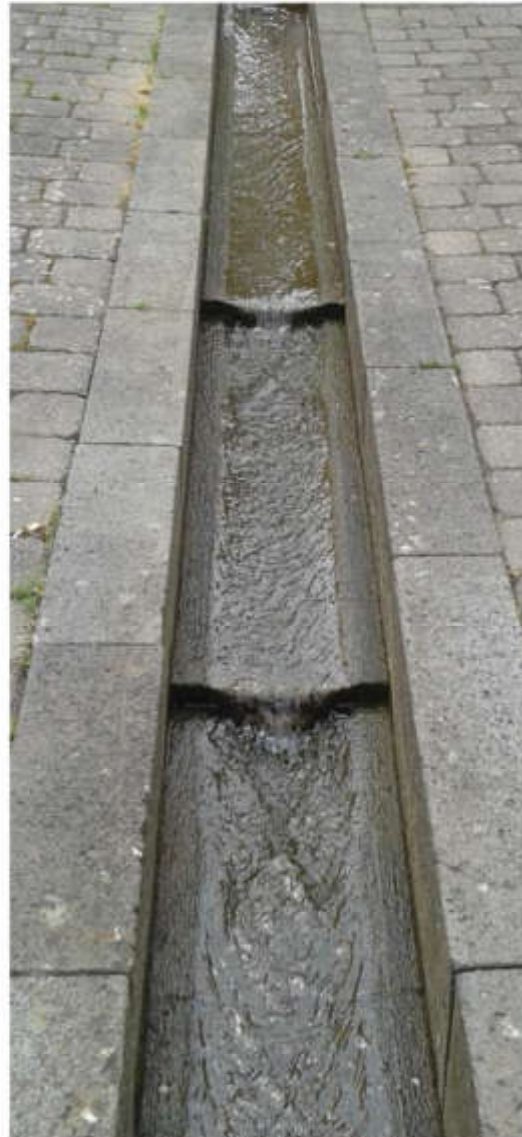
Offene Bachrinne mit Wasserstürzen in Mayen
